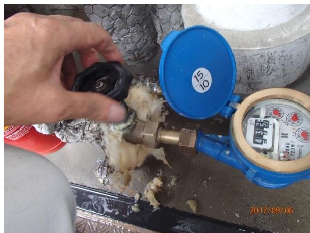
部屋のメーター廻り配管を検証
